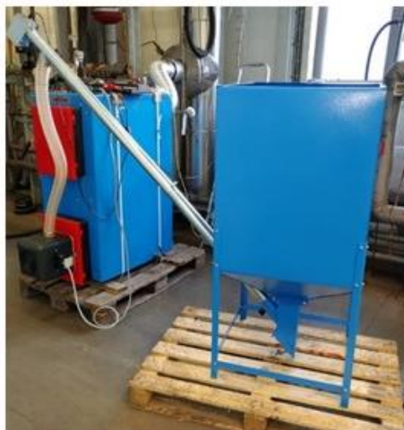
Rys. 8. Przykłady kotłów c.o. z palnikiem na pellet [materiały własne ITPE]
