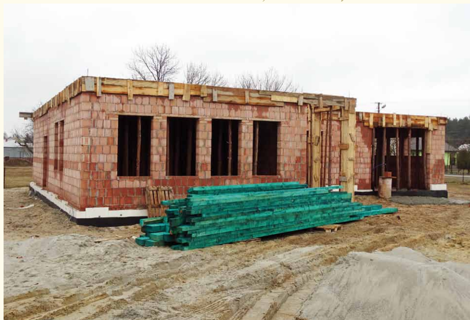
Fot. Remizo-świetlica w miejscowości Dybków
