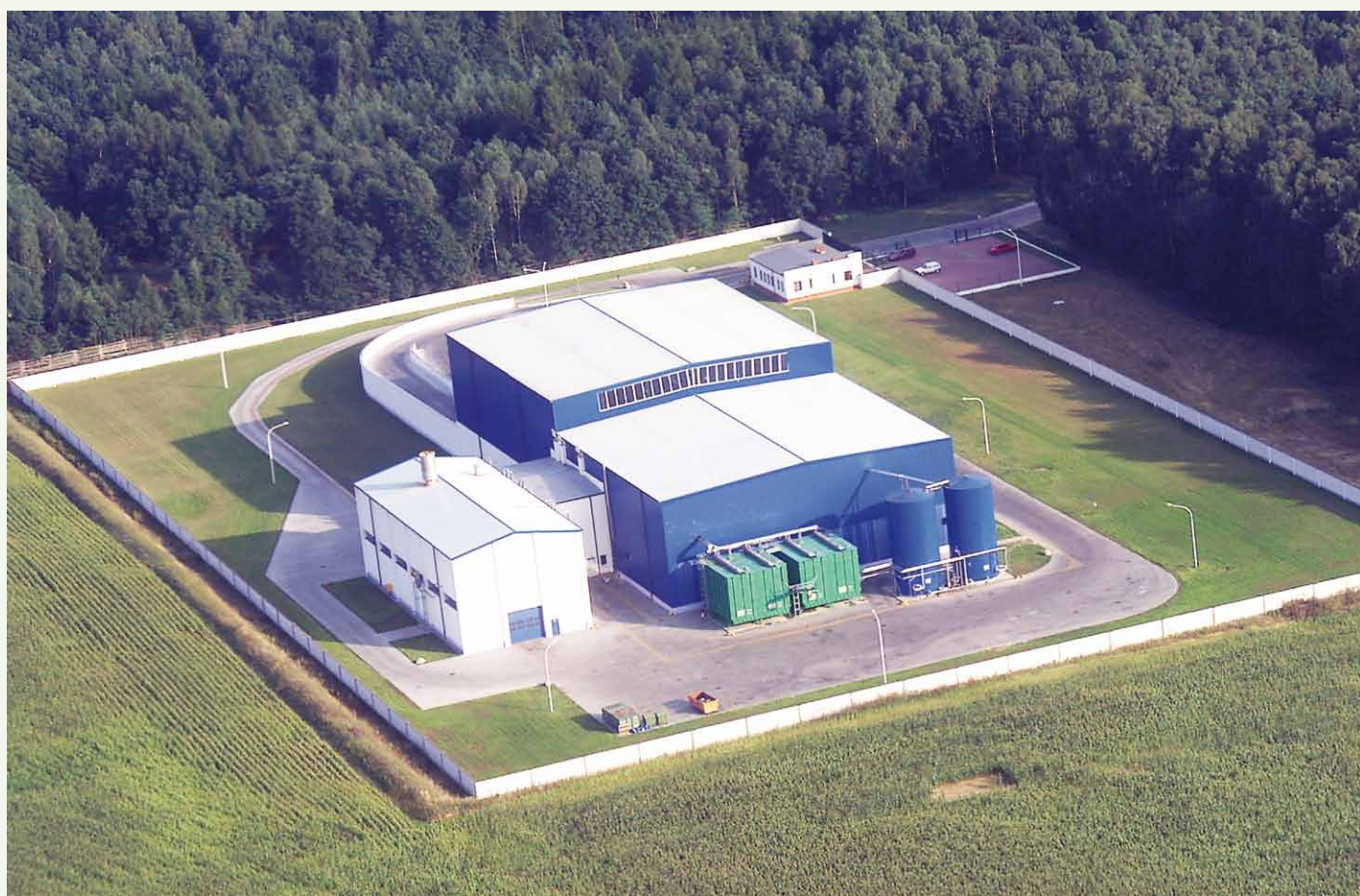
Fot. Jeden z istniejących zakładów utylizacyjnych spółki Farmutil HS zlokalizowany jest w Śmiłowie. Wysokie oceny przyznane obiektowi przez inspekcje Unii Europejskiej, sprawiły, że znalazł się w gronie instalacji referencyjnych.
